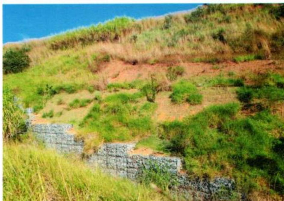
**Figura 39.** Área recuperada após rompimento do sistema de drenagem pluvial
