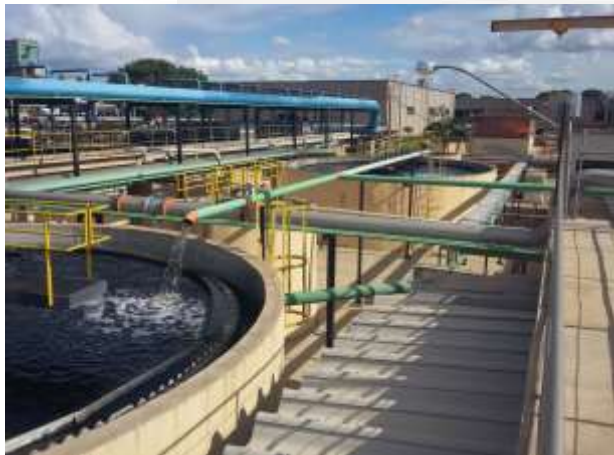
Foto 01. Vista geral da ETE
