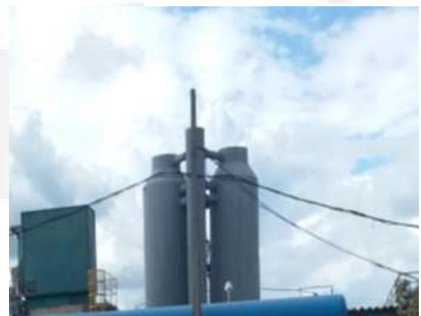
Foto 04. Neutralização por CO 2
