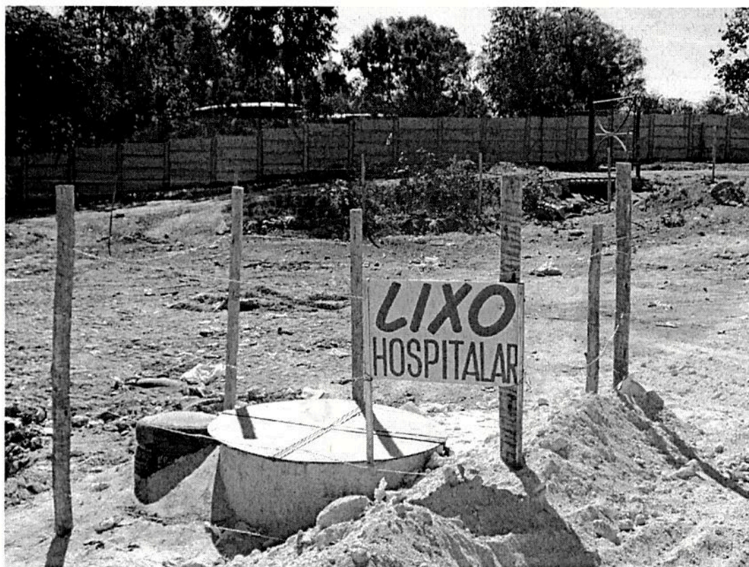
Foto 5: Local de disposição de resíduos de serviços de saúde: fosso de concreto tampado, cercado e identificado.
