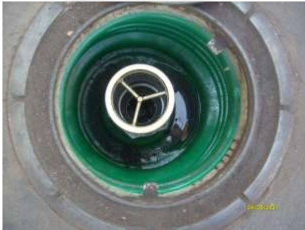
Figura 07: SUMP área de descarga. Fonte: SUPRAM-NM, 2014.
