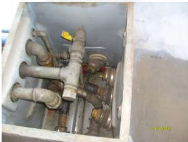
Figura 08: SUMP nas conexões. Fonte: SUPRAM-NM.
