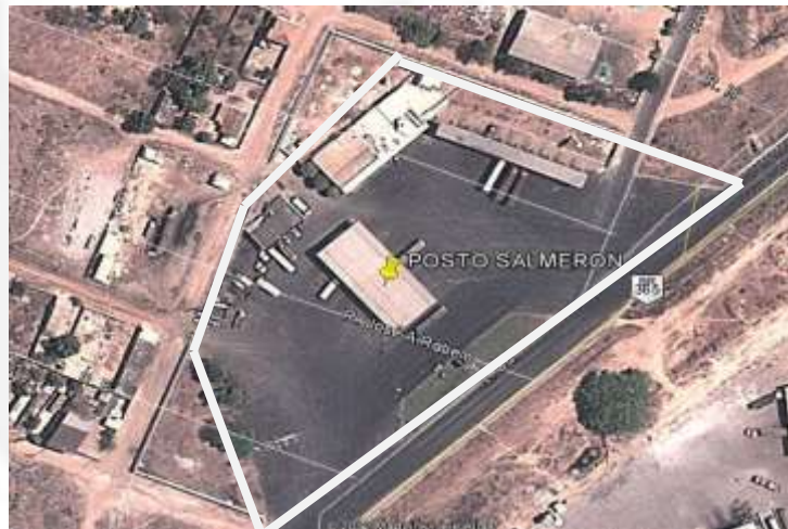
Figura 01: área construída do Posto Salmeron. Fonte: Adaptado de Ambiental Tecnol Consultoria Ltda, 2015.
