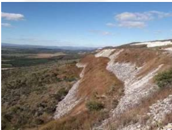
Foto 03. Vista parcial da pilha denominada A em operação com taludes em recuperação.
