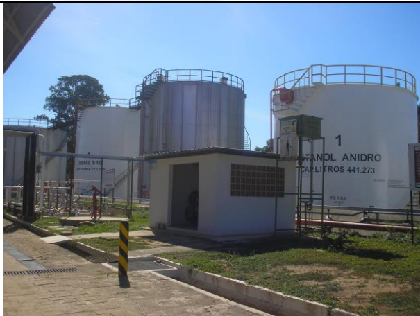
Foto 03. Tanques de armazenamento de combustíveis. Data: 16/04/2015.
