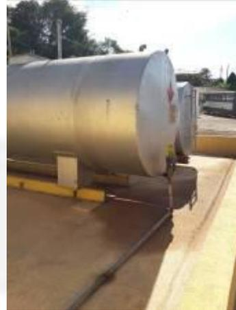
**Foto 06.** Tanques e bacia de contenção
