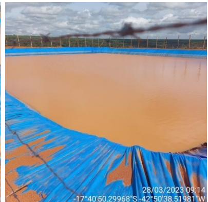
Fotos 13, 14 e 15 – “Piscinões” instalados próximo à silvicultura. Armazenamento de água pluvial para utilização durante os plantios e eventuais incêndios florestais.
