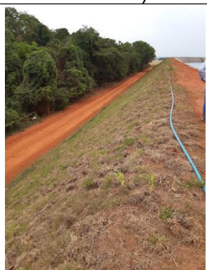
Foto 13. Talude do piscinão do efluente das lagoas de tratamento de dejetos animais (reservatório "off stream")
