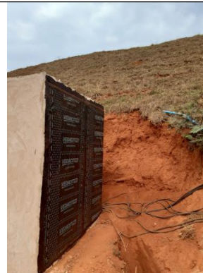
Foto 12 c. Abrigo de máquinas construído na base do piscinão do efluente das lagoas de tratamento de dejetos animais (reservatório "off stream")
