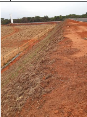
Foto 15. Talude do piscinão do efluente das lagoas de tratamento de dejetos animais (reservatório "off stream")
