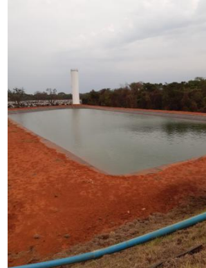
Foto 8. Piscinão de água (reservatório "off stream")
