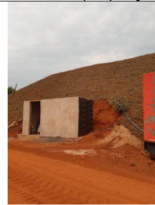
Foto 12 a. Abrigo de máquinas construído na base do piscinão do efluente das lagoas de tratamento de dejetos animais (reservatório "off stream")
