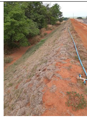
Foto 16. Talude do piscinão do efluente das lagoas de tratamento de dejetos animais (reservatório "off stream")
