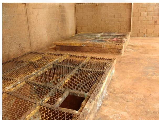
Foto 04. Caixas de solidificação no galpão de armazenamento temporário de resíduos
