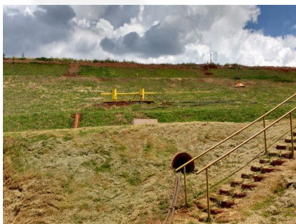
Foto 03. Taludes gramados do aterro classe II
