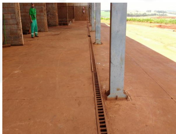
Foto 10. Baías e canaleta na área de armazenamento temporário de resíduos
