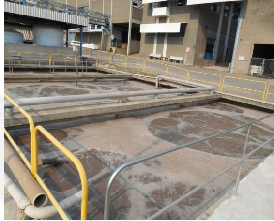
Foto 12: Estrutura da ETE.
