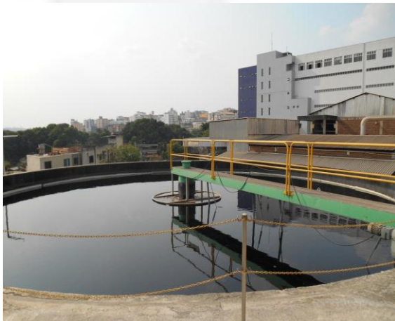
Foto 13: Estrutura da ETE.
