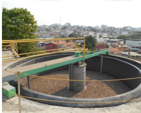
Foto 14: Estrutura da ETE.
