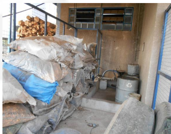
Foto 4: Armazenamento apropriado para res. contaminados.
