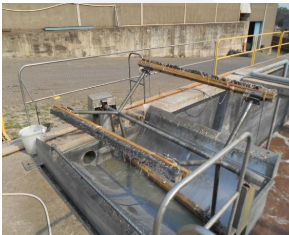
Foto 15: Estrutura da ETE.
