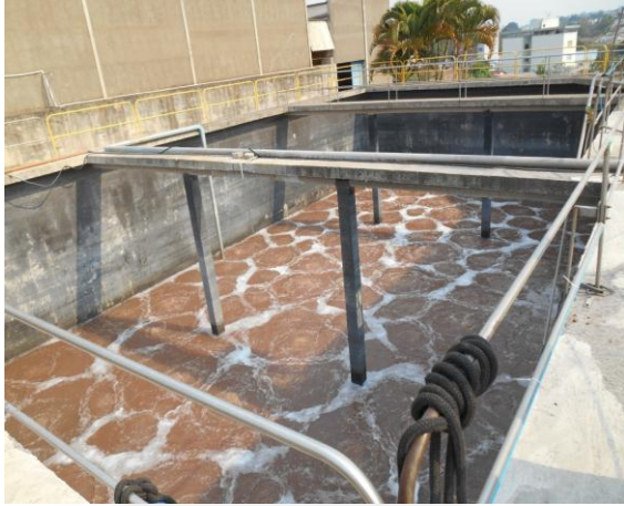
Foto 11: Estrutura da ETE.
