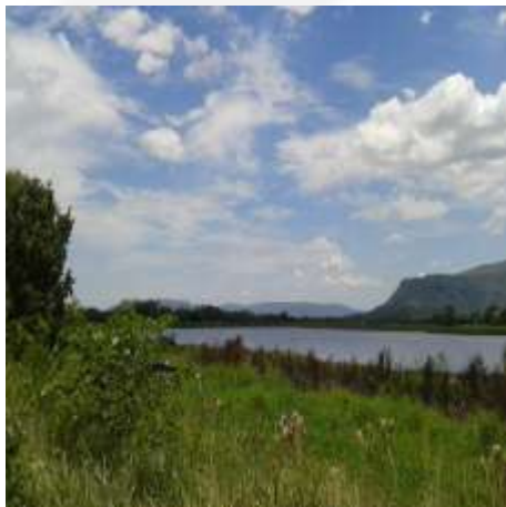
Foto 01. Barragem de Irrigação
