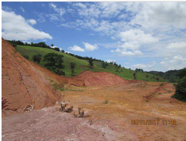
Entrada das futuras instalações do frigorífico.
