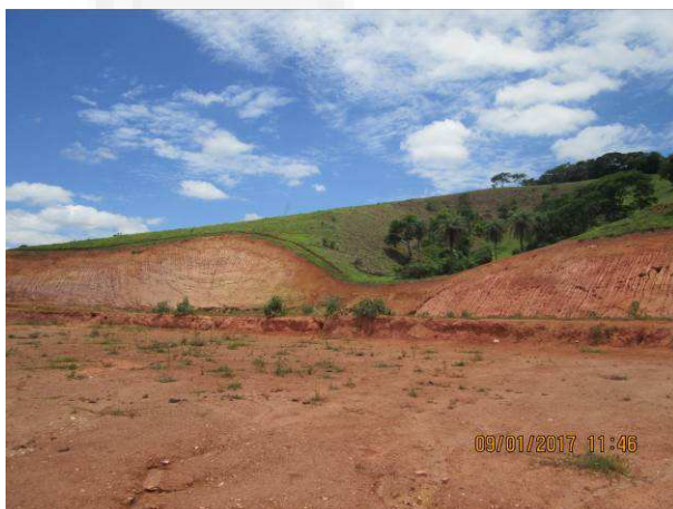
Vista dos taludes de corte a serem recuperados.
