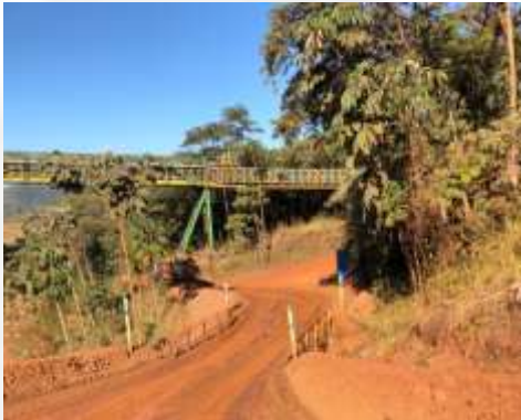
Foto 7 – Vista geral da travessia aérea para suporte da correia transportadora e da estrada passando sobre uma travessia (bueiro).
