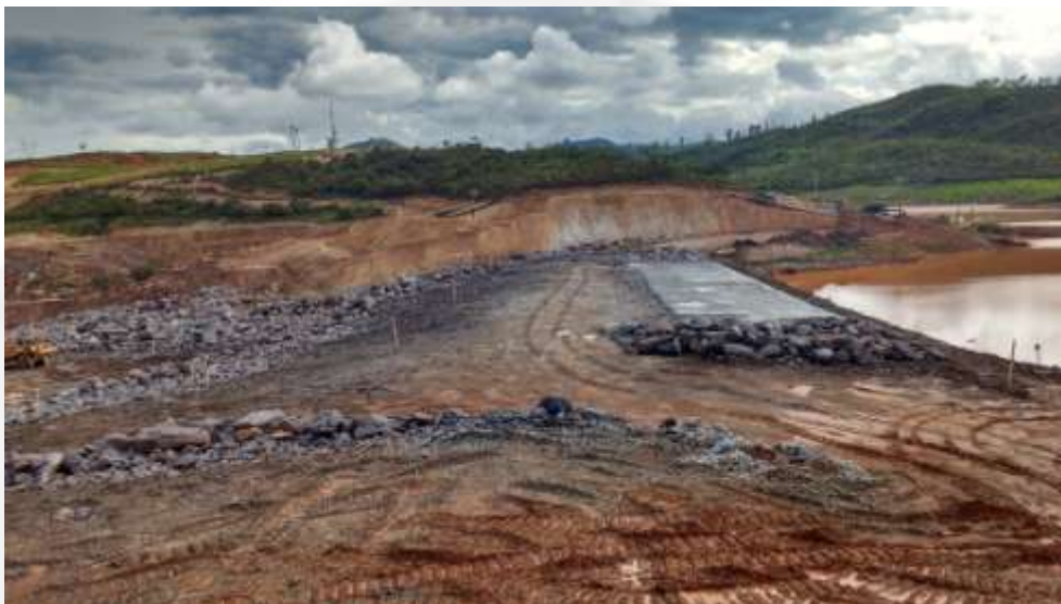
Figura 4.1 Implantação do Dique S3, novembro de 2016.
