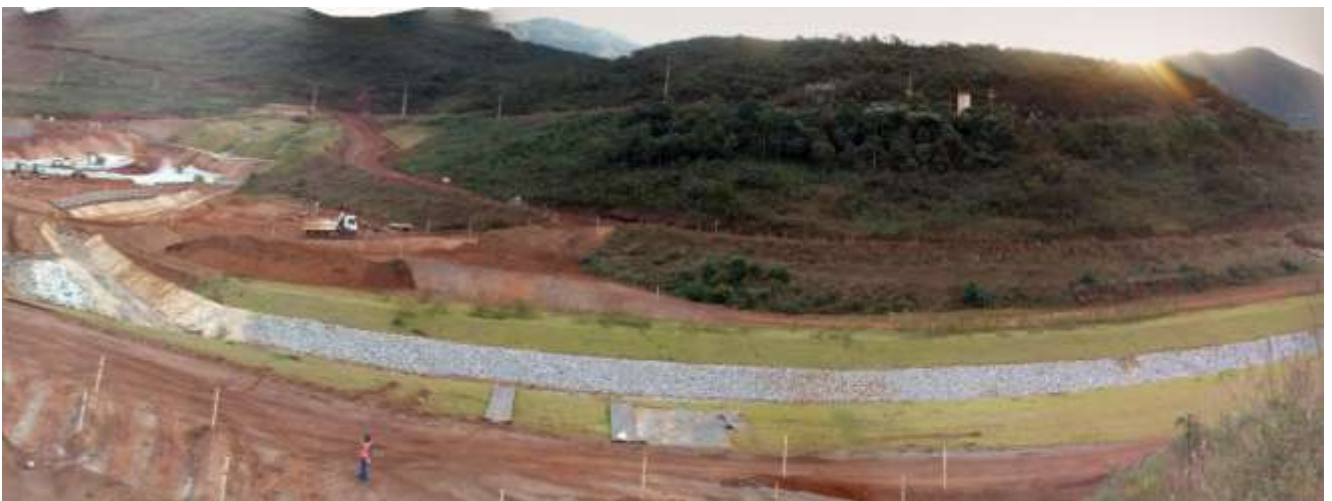
Dique da Oficina (descomissionado) e Dique de Macacos (Obras de adequação)
