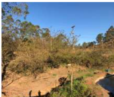
Foto 11 – Vista frontal do bueiro a jusante da cava de Germano desagua no vale do córrego de Germano.
