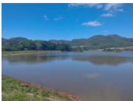
Foto 3. Barragem em curso d'água Fonte: Registro feito em vistoria.
