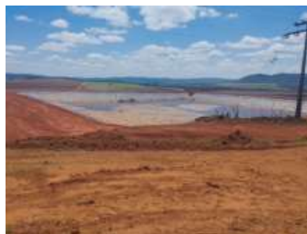
Foto 2. Reservatório de água (Piscinão) Fonte: Registro feito em vistoria.
