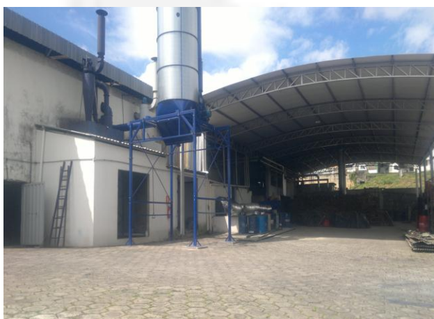
Foto 6. Silo de armazenamento
