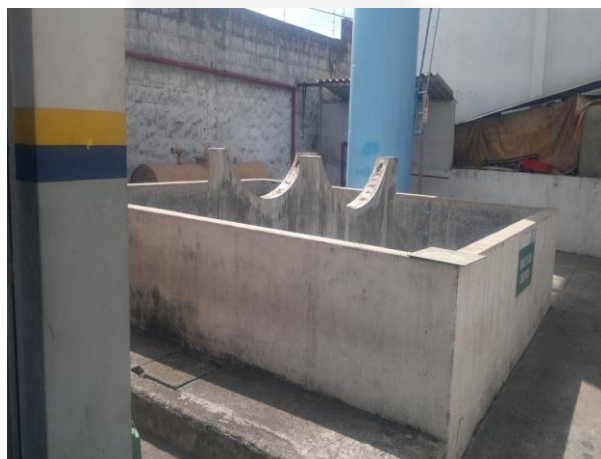
Foto 03. Posto de combustível desativado. Tanque já retirado do local.
