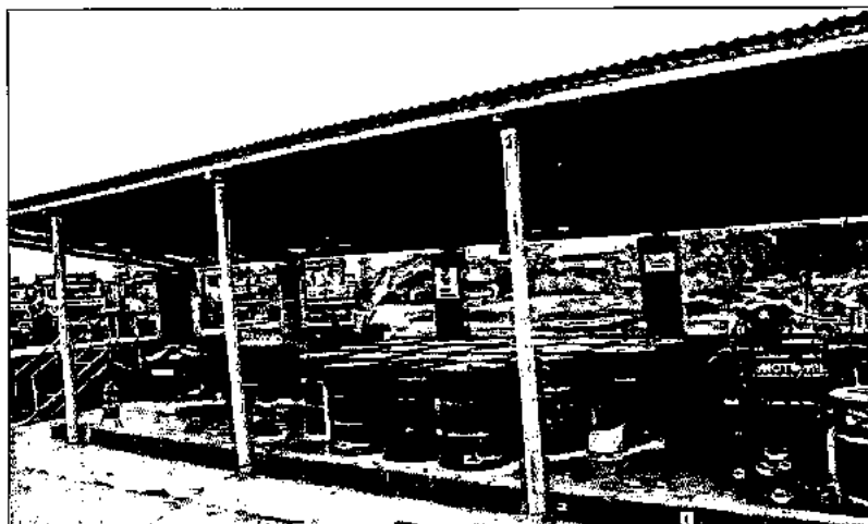
Baia de armazenamento de óleos, graxas e lubrificantes Oficina Engeforte.
