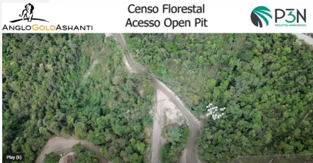
Figura 6: Vistoria remota da área onde foi realizado o censo Florestal (acesso open pit )
