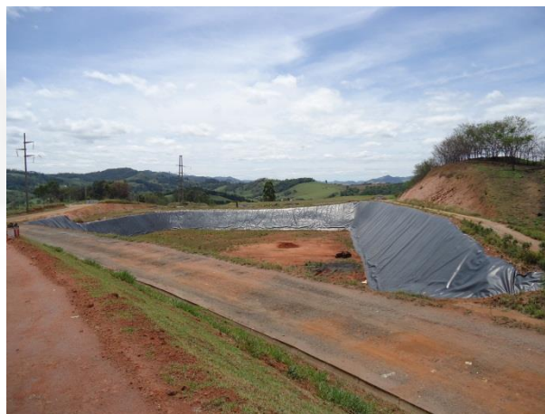
Foto 06. Impermeabilização do aterro
