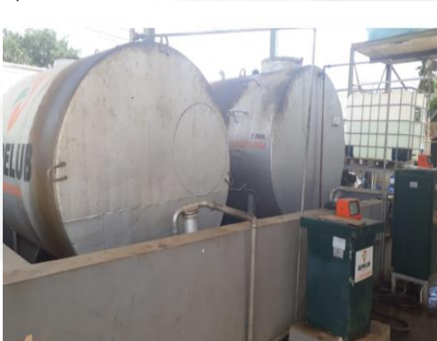
Foto 03. Ponto de Abastecimento.
