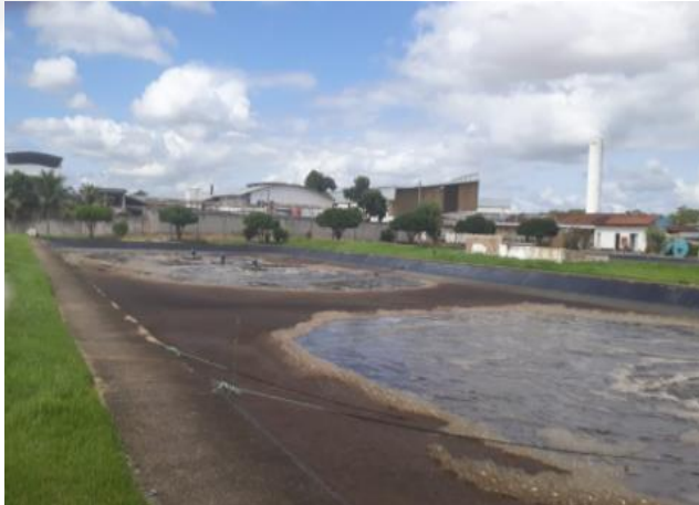
Foto 01. Lagoas para tratamento de efluentes líquidos industriais.
