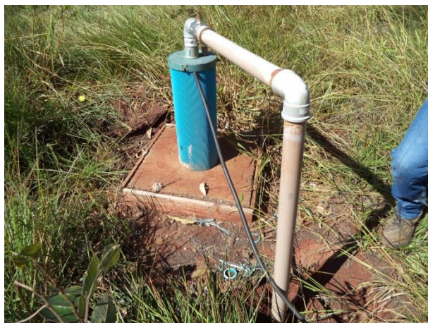
Foto 05. Poço Tubular
