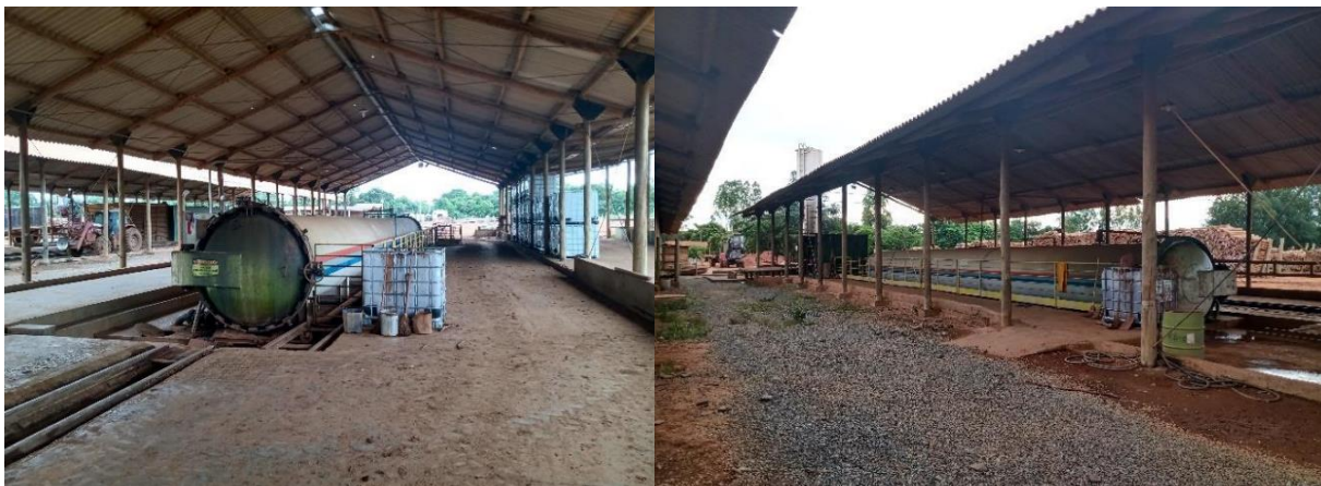
Figura-3. Foto da Autoclave. Fonte: EIA/RIMA do empreendimento.
