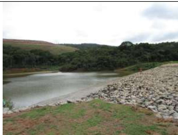
Foto 02. Dique de Contenção de Sedimentos. PDE03 ao fundo. (Data do registro: 18/04/2017).
