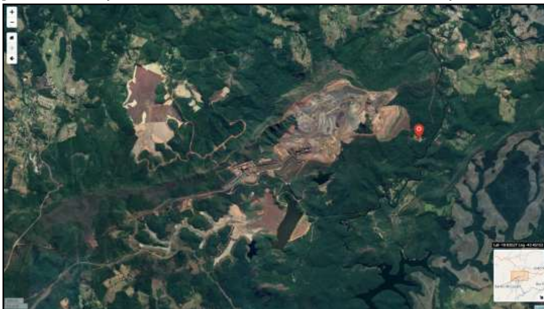
Figura 02: Localização do DCS da PDE-03 na Mina de Brucutu em São Gonçalo do Rio Abaixo.
