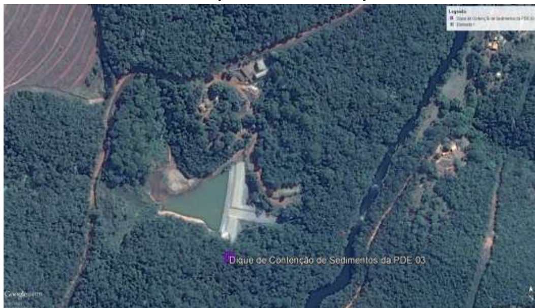
Figura 03: Vista mais aproximada do Dique de Contenção de Sedimentos, com o seu reservatório de acumulação a montante do maciço.
