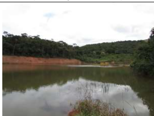
Foto 04. Lago formado no Dique de Contenção de Sedimentos. (Data do registro: 18/04/2017).
