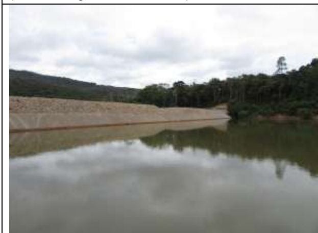
Foto 03. Dique de Contenção de Sedimentos. (Data do registro: 18/04/2017).
