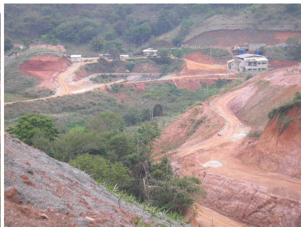
Foto 02: Vias de acesso.
