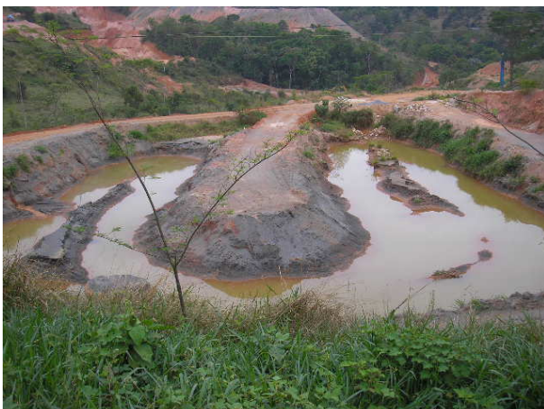
Foto 19: Tanques de decantação de finos.
