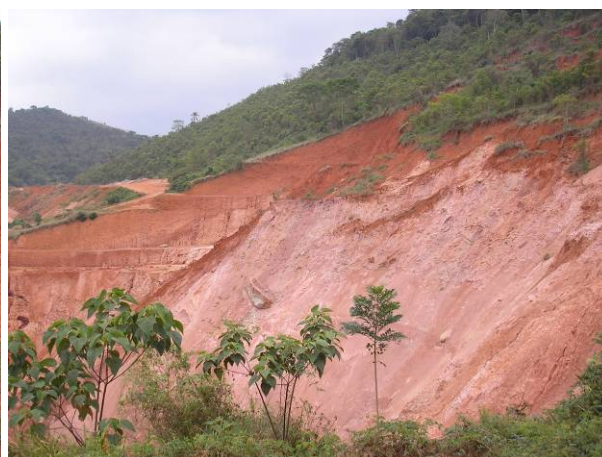
Foto 03 e 04: Decapeamento da Lavra Subterrânea, taludes desestabilizados.
