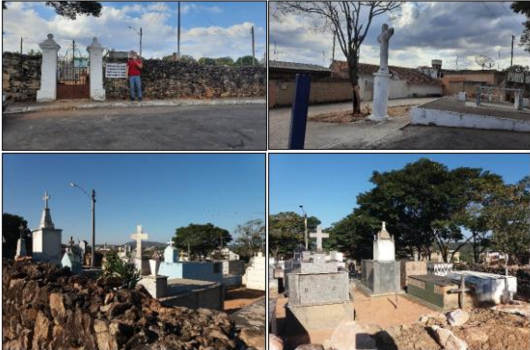
Figuras 336, 337, 338 e 339: Vista do Cemitério Municipal de São José dos Salgados Fonte: YKS Serviços, 2021.
