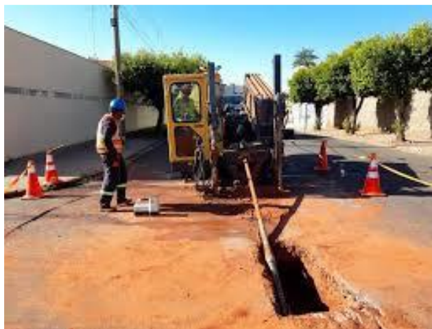
Figura 17: Exemplo de utilização do Método Não Destrutivo destacando-se a pequena
