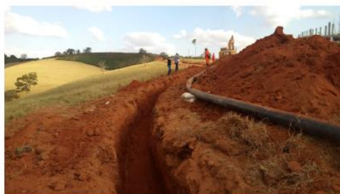
Figura 14: Exemplo do processo de abertura de vala. (Fonte: EIA – Gasmig, 2018).
