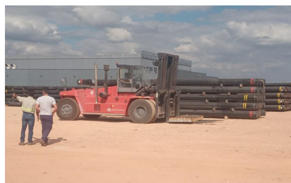
Estocagem de tubos (área pulmão).
