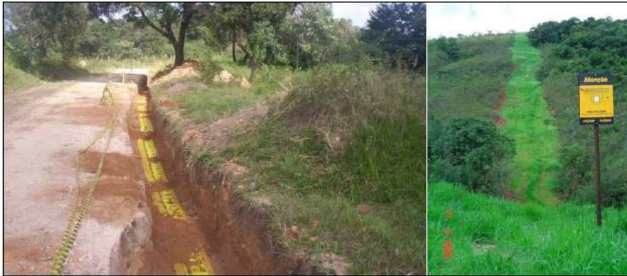
Figura 16: Sinalização do traçado (Fonte: Gasmig, 2023).
