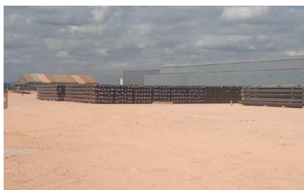
Estocagem de tubos (área pulmão). O imóvel é destinado para armazenagem de materiais e
