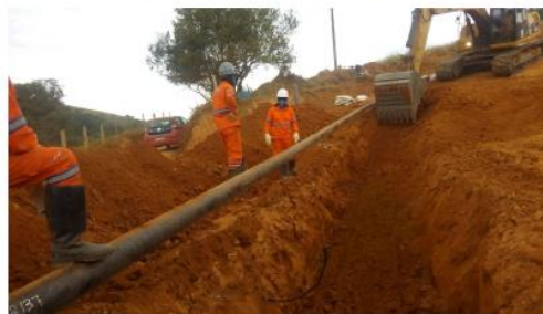
Figura 14: Exemplo do processo de abertura de vala. (Fonte: EIA – Gasmig, 2018).
