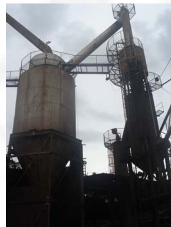
Figura 4. Lavador de gás do Alto-Forno 1.
