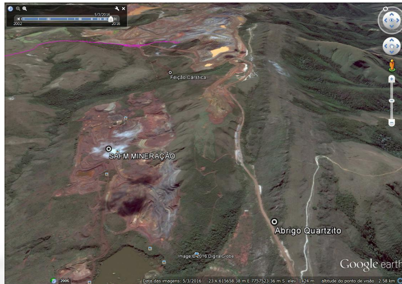
Figura: ADA do empreendimento e as cavidades identificadas no entorno.
