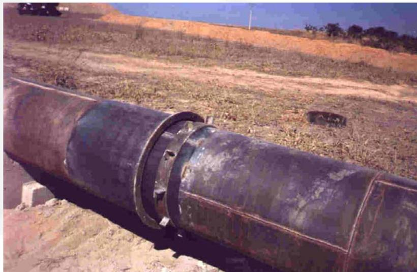
Figura 4. Detalhe da estrutura para absorver a dilatação do material. Fonte: EIA do empreendimento.
