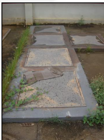
Foto 03: Caixa Separadora de Água e Óleo
