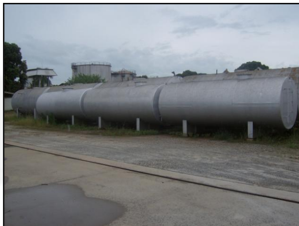
Foto 02: Tanques de armazenamento removidos
