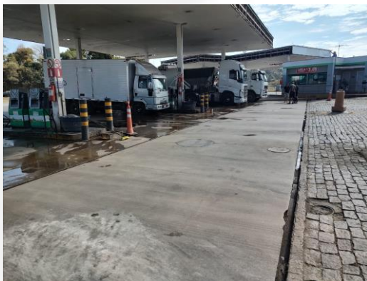
Foto 3: Pista abastecimento caminhões
