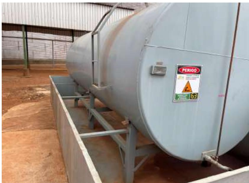
Foto 2- Tanque de Combustível (capacidade de 14.900 L) – Fonte RADA
