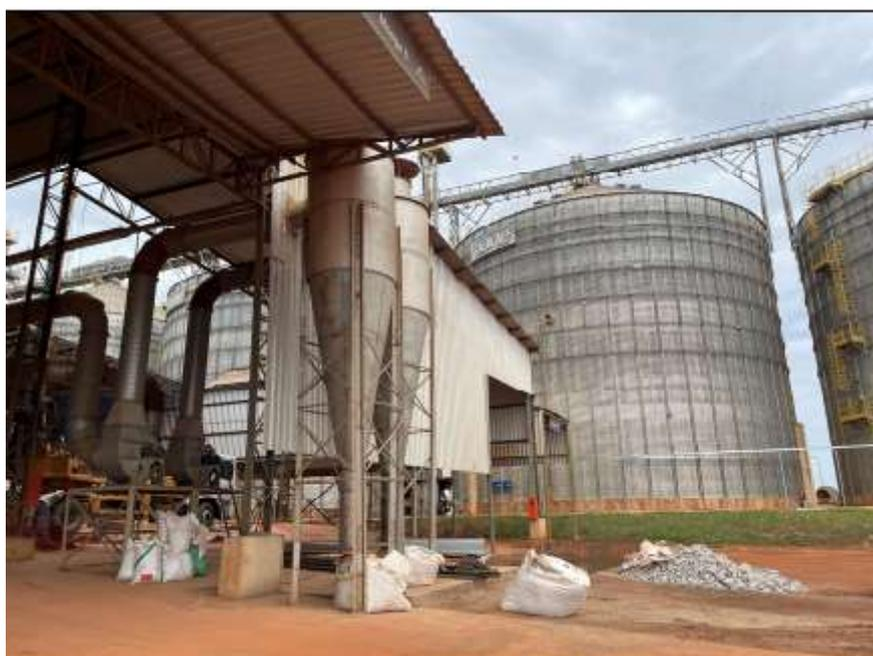
Foto 4 - Coletor de material particulado - Fonte RADA
