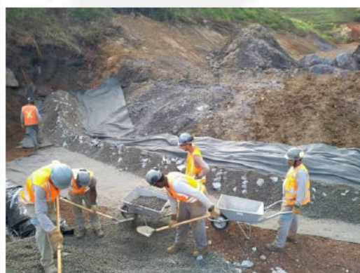
Figura 5: Dreno de fundo da pilha
