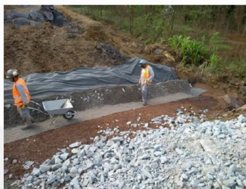
Figura 4: ampliação do dreno de fundo
