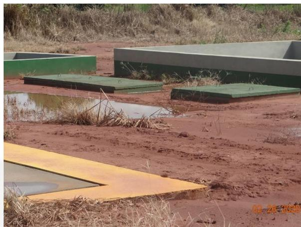
**Figura 6. CSAO instalada na área de abastecimento de máquinas e veículos**
