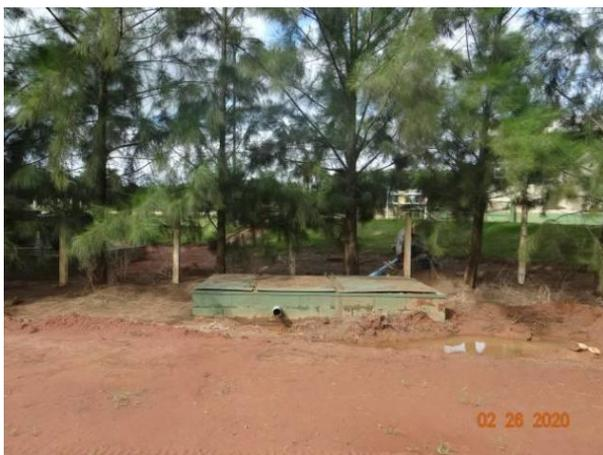
**Figura 5. CSAO instalada na portaria (desinfecção de veículos)**
