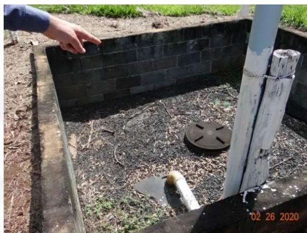
**Figura 8. Fossa biodigestora (refeitório e escritório)**
