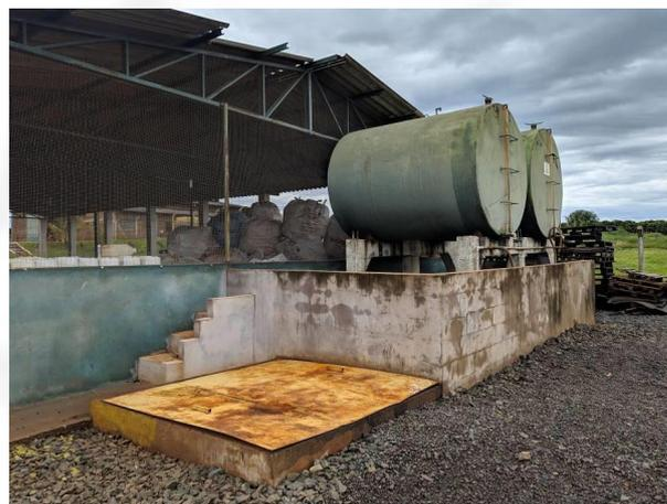
Figura 2. Armazenamento de óleo mineral, bacia de contenção e CSAO
