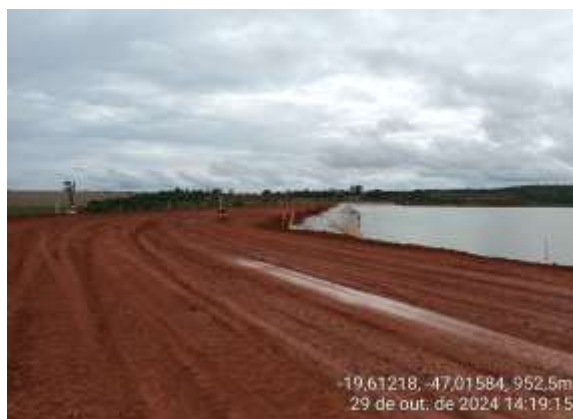
Foto 04. Barragem B6 - Alçamento cota 965 m.
