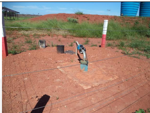
Figura 06. Poço tubular
