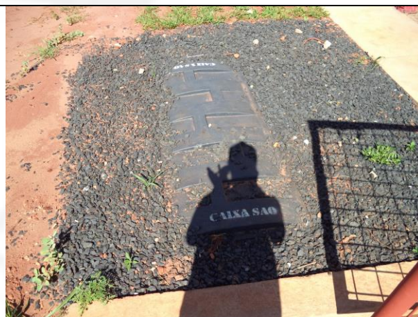
Figura 08. Caixa separadora de água e óleo
