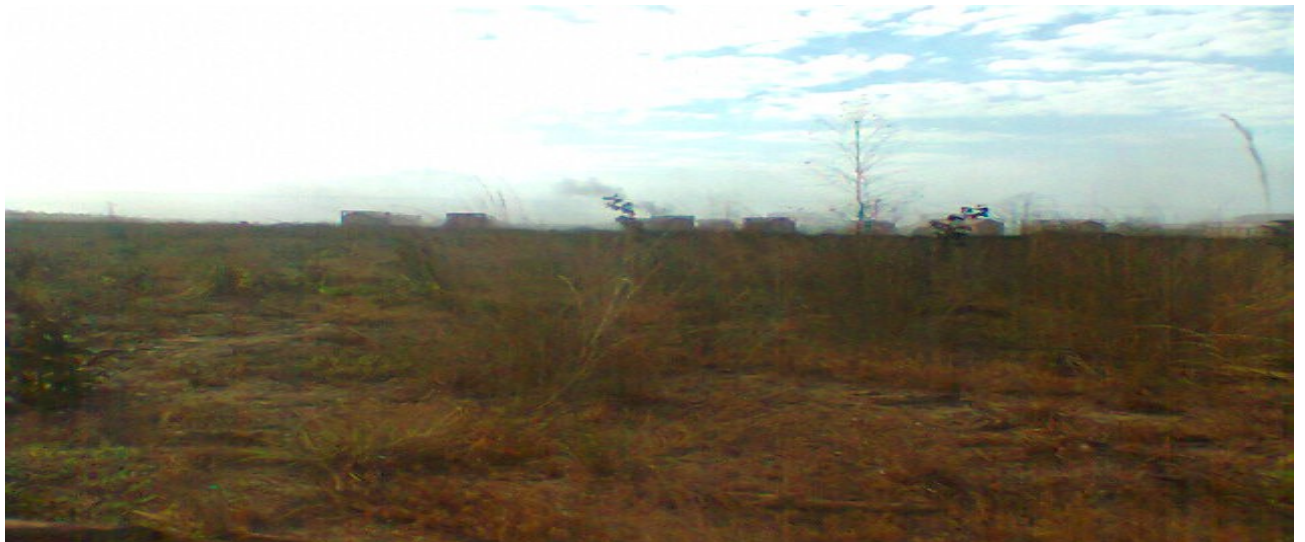
Foto V – Visão da Planta de Carbonização
