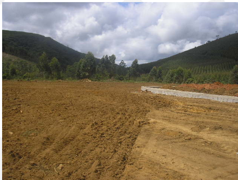
Foto 6. Área para instalação das valas
