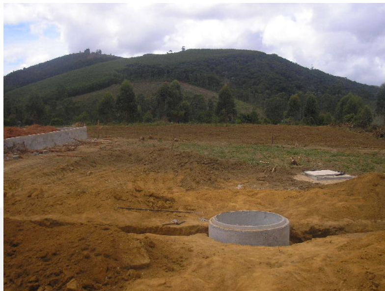
Foto 5. Área para instalação das valas.
