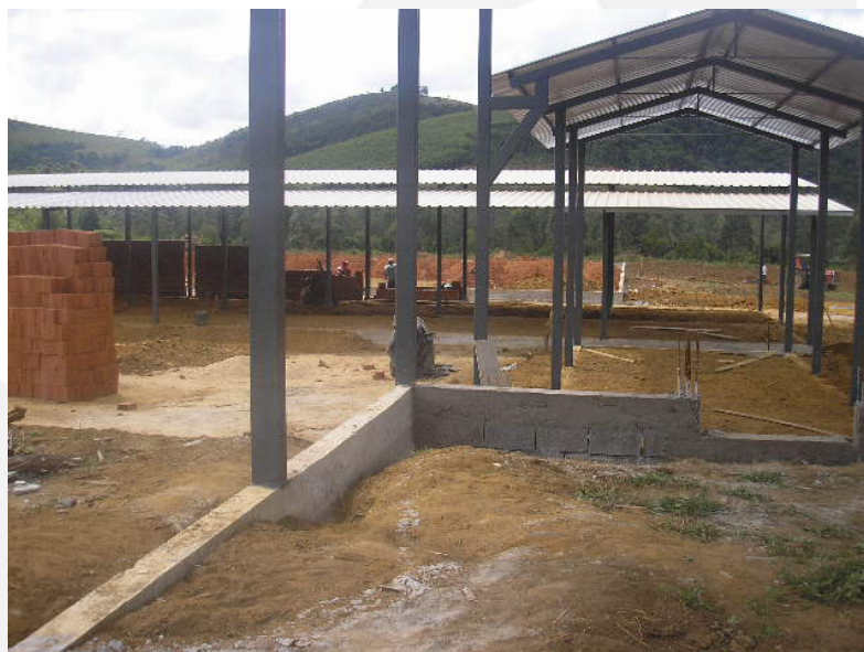
Foto 2. Galpão de recebimento e triagem de lixo.
