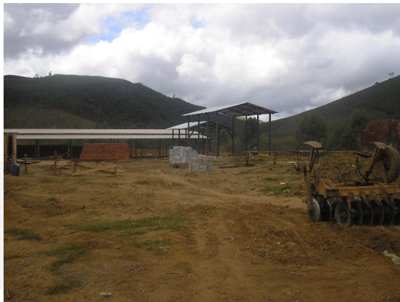
Foto 1. Arranjo geral das instalações da usina.
