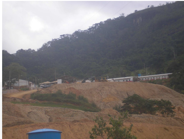
Foto 06. Vista geral do Canteiro de Obras e alojamentos
