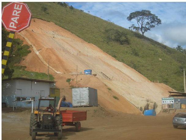
Foto 11. Talvegues área da entrada do Túnel de Adução.
