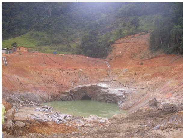
Foto 07. Escavação do Túnel de Adução na sua saída e para a Casa de Força.
