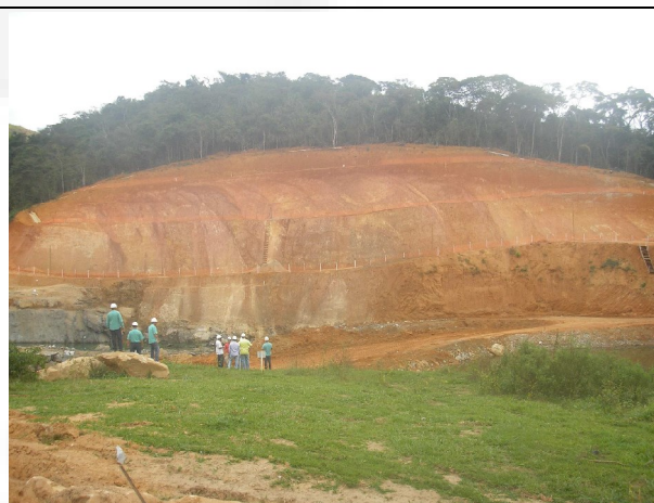
Foto 02. Vista da Ombreira direita do eixo do barramento e enscadeira.
