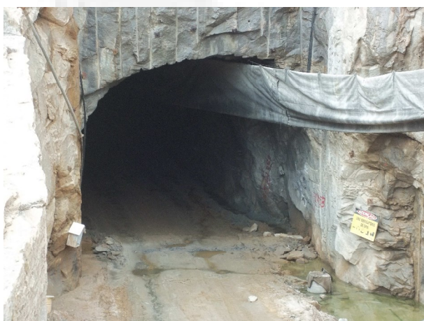
Foto 03. Escavação do Túnel de Adução na Tomada d'água.
