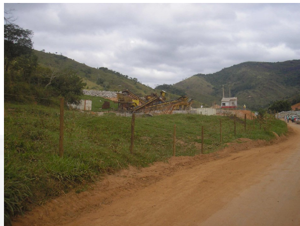
Foto 12. Vista geral do Britador.
