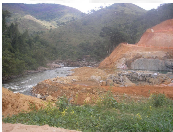
Foto 04. Eixo do barramento no início das obras
