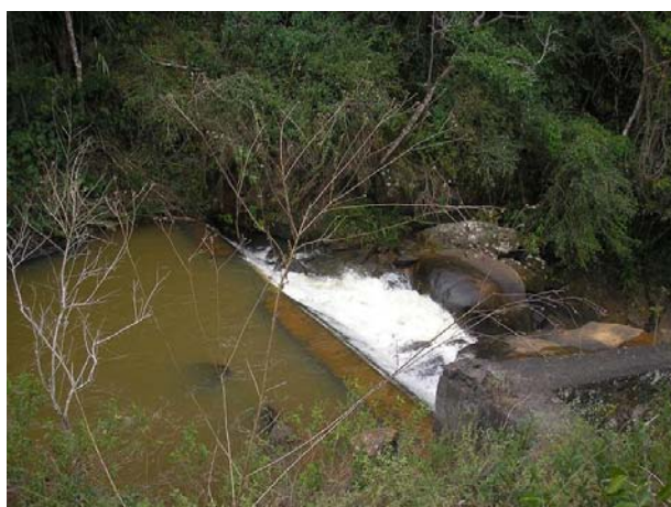
Foto 01. Barramento existente no local
