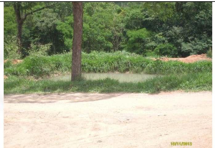
Foto 09. Cacimba para a contenção de sedimentos e acúmulo de água.
