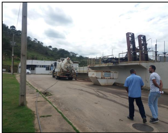
Figura 2-Área dos reatores e estrutura de apoio
