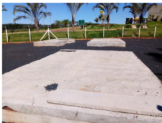
Sistema de Tratamento de Efluentes - Caixa SAO e Fossa séptica com Filtro.
