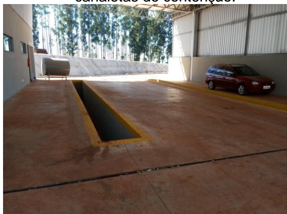
Área de Troca de Óleo – Cobertura e canaletas de contenção.
