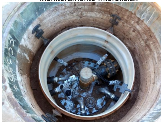
Boca de acesso ao tanque – Sump e Monitoramento Intersticial.
