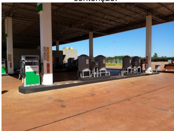
Pista de abastecimento de veículos pequenos - Cobertura e canaletas de contenção.
