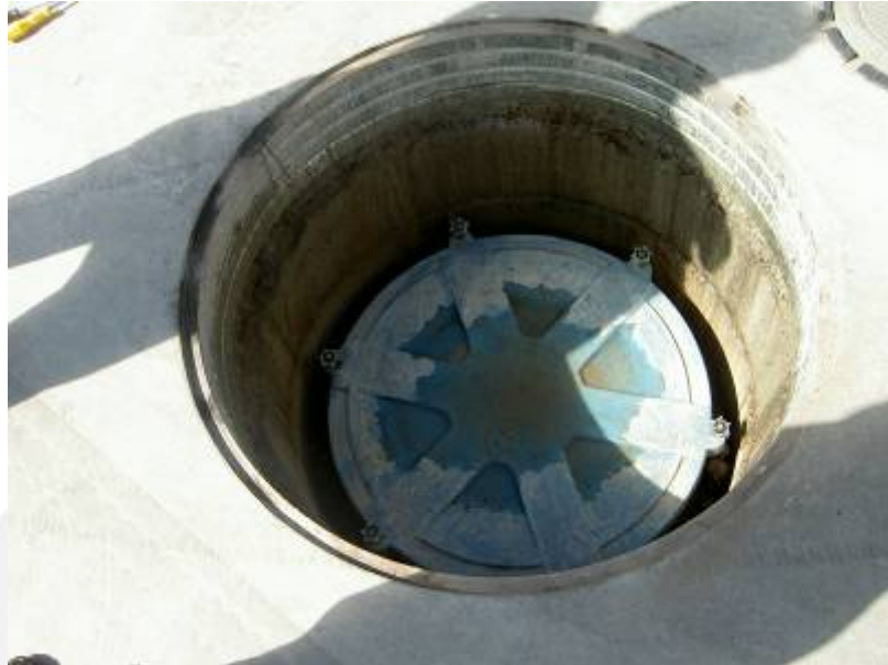
Foto 05: Boca de visita.
