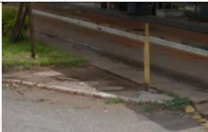
Figura 3 – Área onde se encontra o poço de captação de água subterrânea
