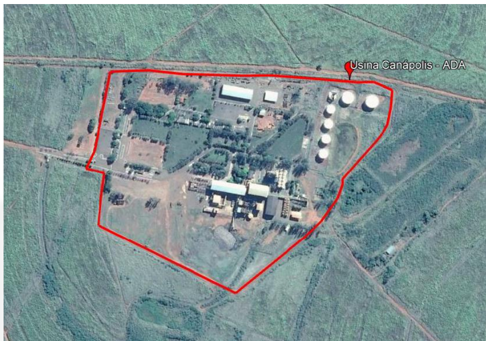
Imagem 04: ADA do empreendimento.
