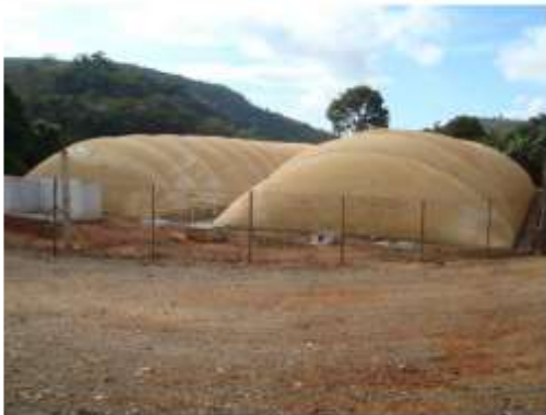
Foto 01: Biodigestores já instalados
