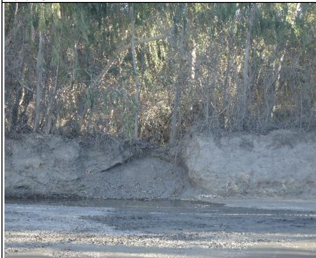
Foto 15. Cacimba para contenção de águas pluviais.
