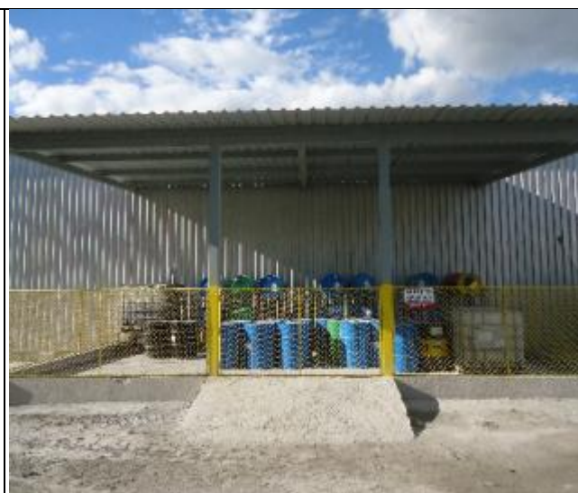
Foto 10. Depósito temporário de resíduos sólidos contam.
