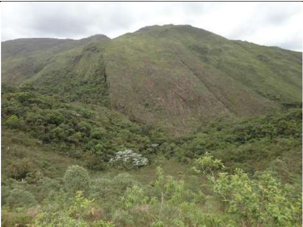
Figura 3: Área de supressão vertedouro
