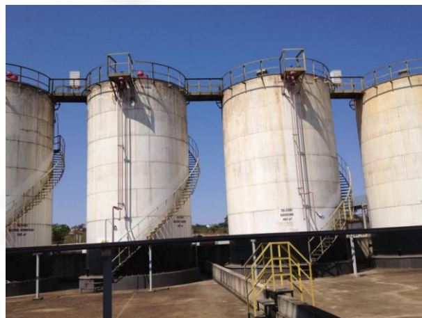
Foto 02. Tanques já instalados
