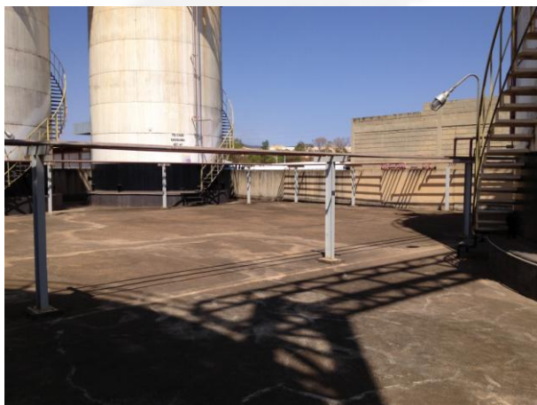
Foto 01. Área de tancagem
