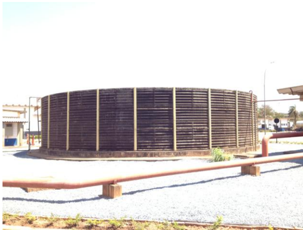
Foto 09. Tanque de água para combate à incêndio
