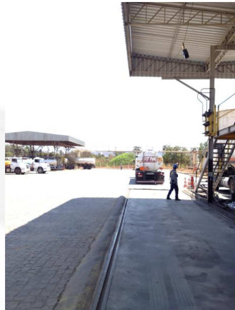
Foto 10. Cobertura e canaletas na PLECT
