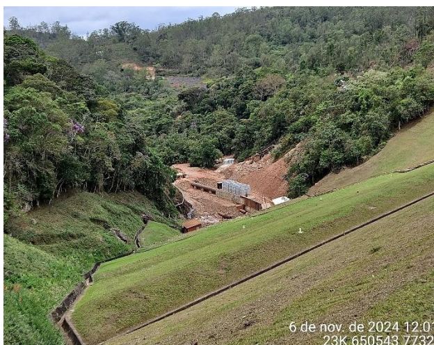
Foto 5: Talude da barragem do Ribeirão Cachoeira e, ao fundo, Casa de Bombas.
