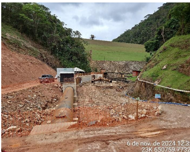
Foto 29: Casa de Força sendo implantada no leito do ribeirão Cachoeira.
