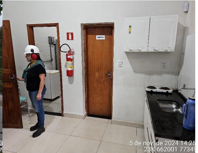
Foto 26: Refeitório e banheiro da Casa de Força da CGH Funil.
