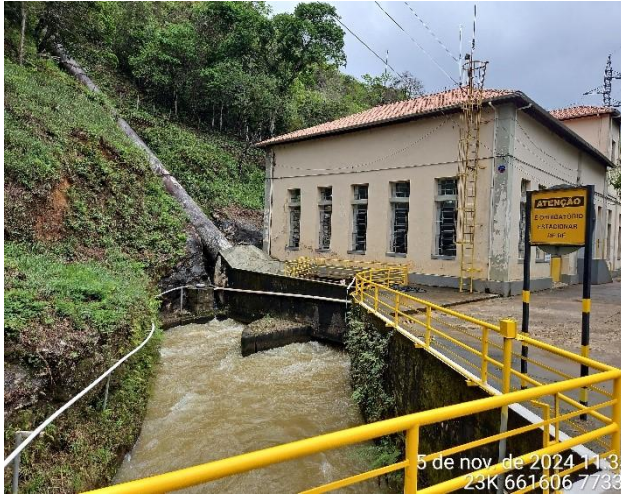
Foto 19: Casa de Força da CGH Salto.
