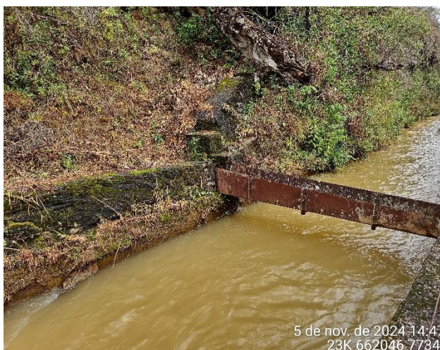
Foto 9: Estrutura de bicame que serve para transposição da água de escoamento superficial no canal de adução.
