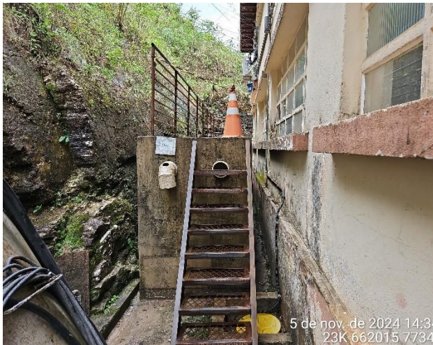
Foto 39: CSAO localizada ao lado da sala de máquinas da Subestação Funil.
