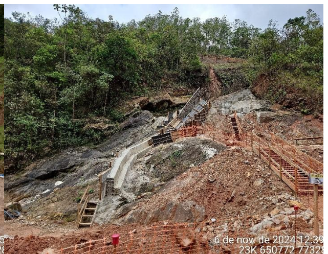
Foto 30: Adequação do canal do vertedouro como medida de proteção das estruturas da Casa de Força que está sendo implantada.
