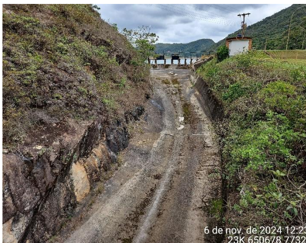
Foto 3: Rampa de vazão do vertedouro.
