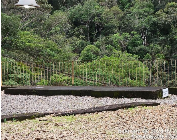
Foto 37: CSAO da Subestação Caboclo.
