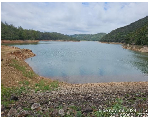
Foto 1: Lago da barragem de Ribeirão Cachoeira.
