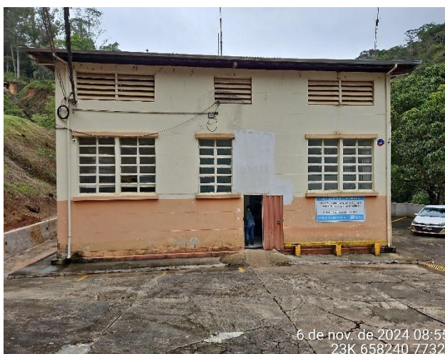
Foto 15: Casa de Força da CGH Caboclo.
