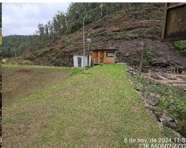
Foto 4: Casa de operação da barragem.
