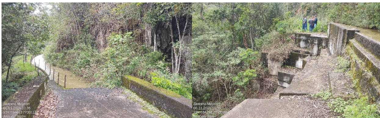
Foto 59. Canal de adução próximo ao encontro com o córrego do Forjo. Na encosta afloram litótipos do Grupo Maynard/ Complexo Antônio do Pirapetinga. Foto 60. Contenção de encosta associada ao canal de adução próximo ao córrego do Forjo.
