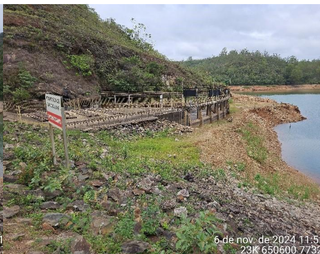
Foto 2: Vertedouro na parte alta do barramento.
