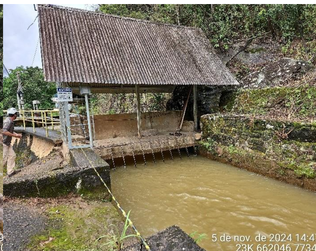
Foto 8: Ponto onde o canal chega ao conduto forçado. No local são instalados vertedouros para limpeza (a esquerda da foto), grades para retenção de material que possa vir a danificar a estrutura da turbina.
