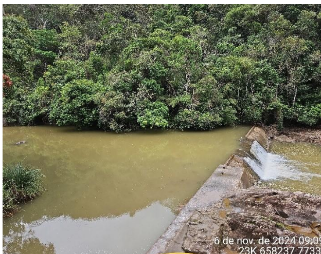
Foto 7: Represamento na CGH Caboclo para controle do canal da CGH Salto.
