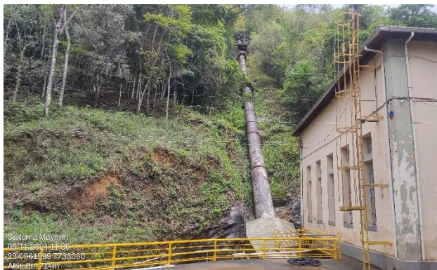
Foto 49. Conduto forçado conectando o canal de adução à Foto 50. Rio Mainart: presença de grande quantidade de central de geração hidrelétrica. Vegetação do tipo FES e blocos de rochas tamanho matacão (Grupo Maynard/ afloramento de litotipo do Grupo Maynard/ Complexo Antônio do Pirapetinga. CGH Salto) neste trecho. CGH Salto.
