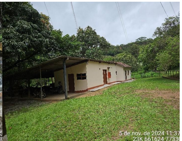
Foto 24: Estrutura com almoxarifado e escritório próximos à Casa de Força da CGH Salto.
