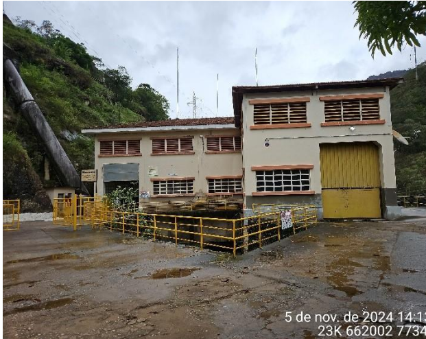
Foto 25: Casa de Força da CGH Funil.
